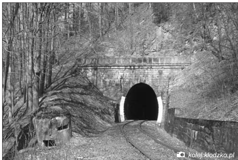
Tunel w Kulinie wjazd od strony Lewina Kłodzkiego
