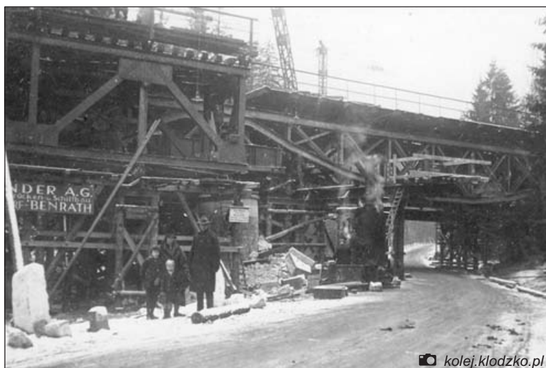
Budowa wiaduktu kolejowego w „Piekielnej Dolinie” koło Polanicy-Zdroju
