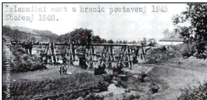
Prowizoryczny most kolejowy łączący Kudowę-Zdrój z czeskim Nachodem
