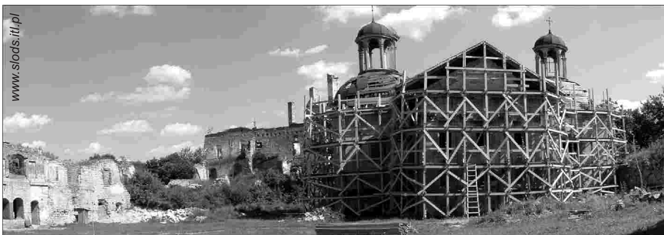
Prace remontowe kościoła przyzamkowego stan na 2005 rok
