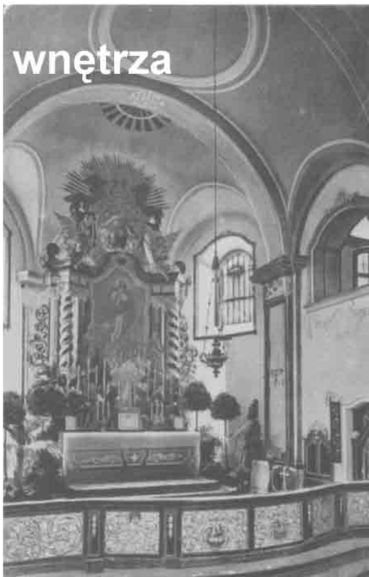
Ołtarz główny z lat 30 ubiegłego wieku
